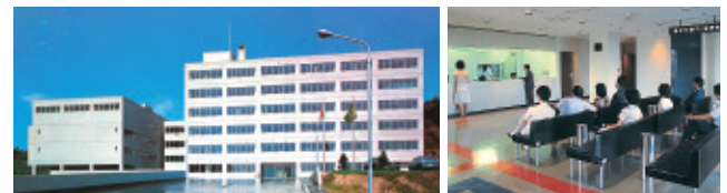
左) 1978年10月、歯学部・歯学部附属病院が完成。歯学部附属病院は地下1階、地上6階建ての鉄筋コンクリート造り。治療ユニットは136台を備えた。右) 開院当時の歯学部附属病院待合ホール。
